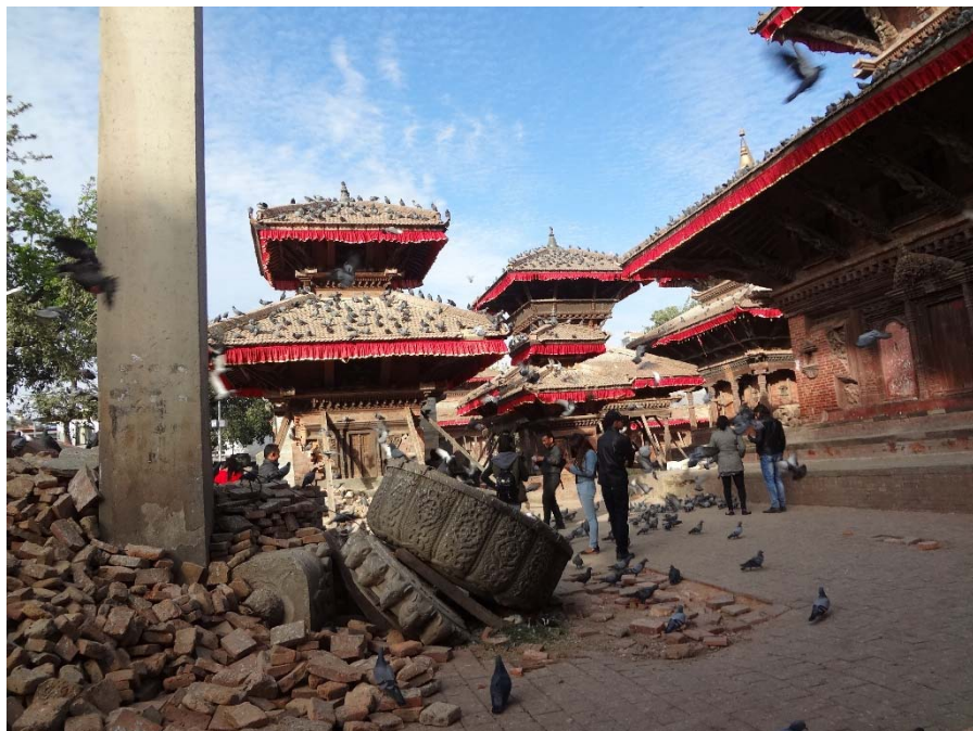
写真 2. 修繕作業の進むダルバール広場
