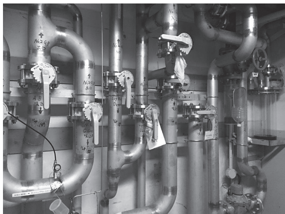
図3. ガスバッグ直下の配管とバルブ.
