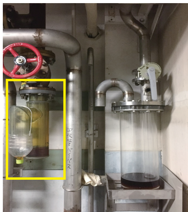
図2. ガスバッグ直下に設置された2つの安全器。
