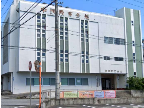
写真1 「中頭教育会館」の外観。 かつて、この建物の最上階のフロア でピアノ教室が開かれていた。 (2025年2月 筆者撮影)
