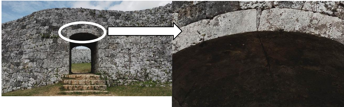
【写真5（上左）二の郭の城門、写真6（上右）眉石と楔石の拡大図】
