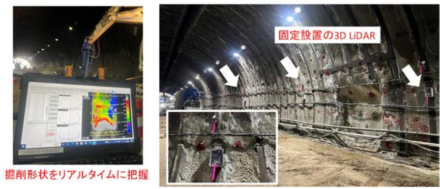
図-4.45 インバート掘削の出来形管理を自動化するために施工箇所に設置した 3D LiDAR
