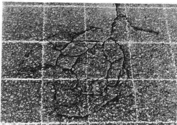
写真-3 名神高速道路・ 舗装上面の損傷状況 (昭和54年4月)
