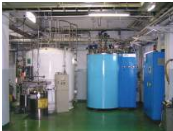
2002年に豊中分室に設置された Linde 社製 TCF50型ヘリウム液化装置。
