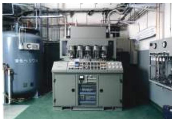
1993年に豊中分室に設置されたPSI社製Model2210Jヘリウム液化装置.
