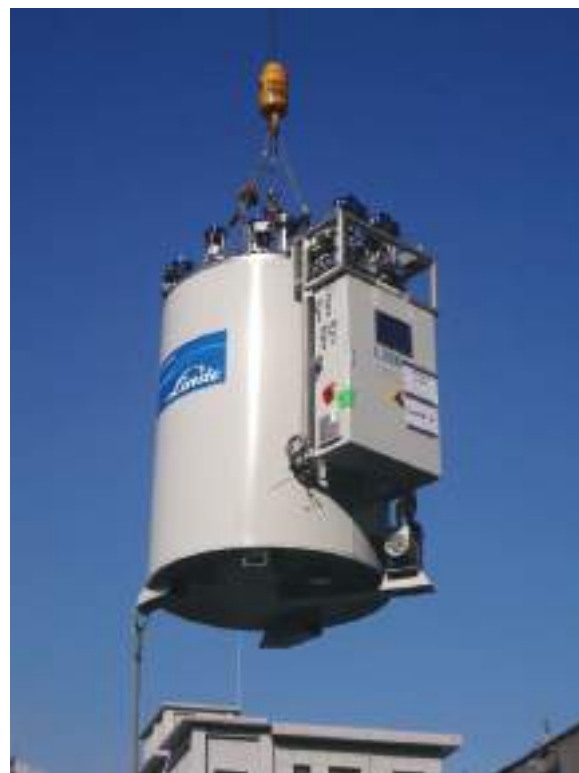
2016年のヘリウム液化装置更新工事の様子【豊中】.
