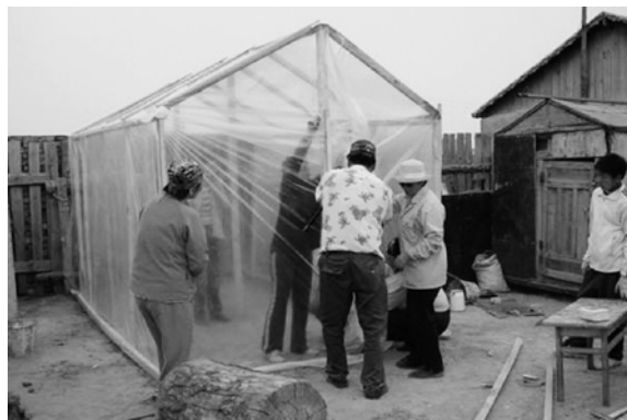
写真3 野菜用のビニールハウスをシングルマザーの家庭に立てている
