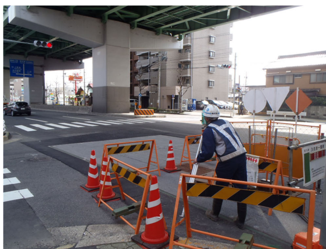
(b) 既存高架の変位計測（手動）
