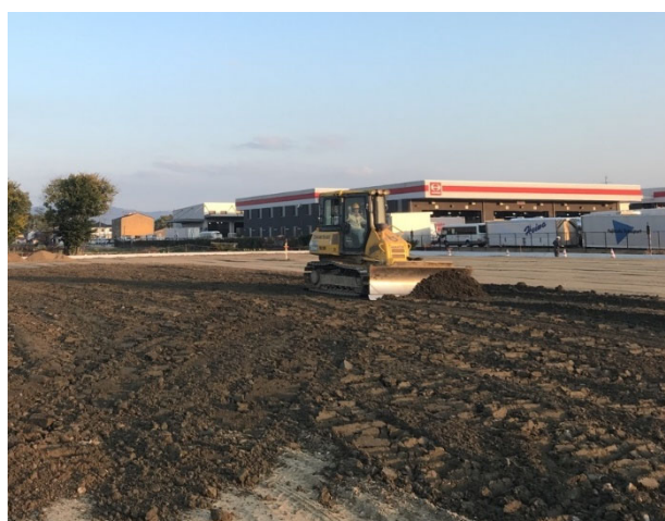
図 36 施工状況（敷均し）
