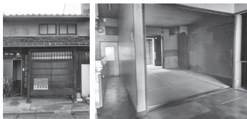
図 1 改修前。大正頃の建物に昭和の内装という西陣で見られる典型的な使われ方の町家。薄暗い。
