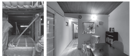
図 2 傾いた柱の調整（左）渡り廊下を作り、水回り棟を新設。中庭を設えることで採光を確保した（右）
