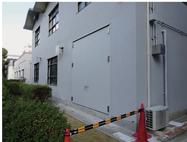
図3. 機器搬入用扉
