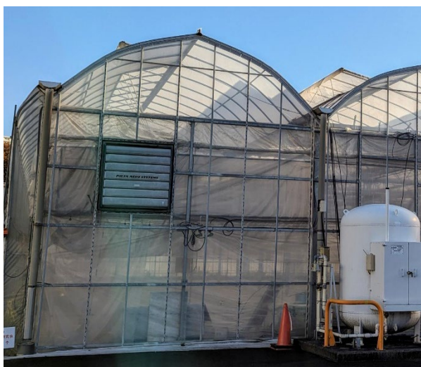
図2 対象施設外観（千葉大学環境健康フィールド科学センター太陽光型植物工場 5号棟）
