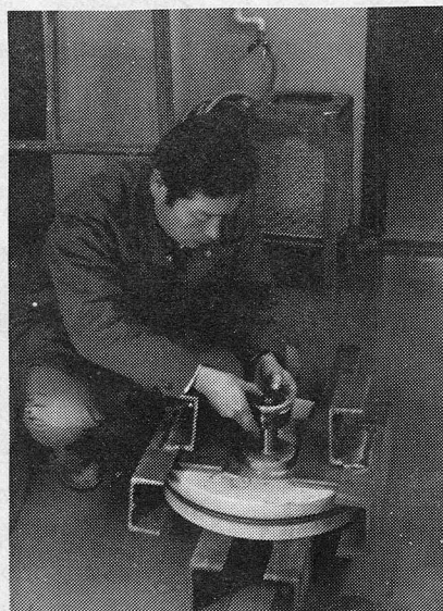
液化機のシャフト修理状況
