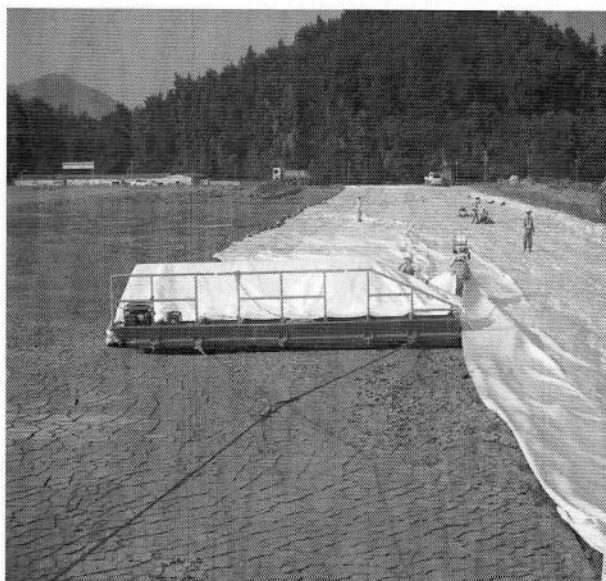
a) ジオテキスタイル敷設工事
