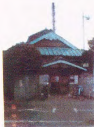
写真-4.7 浦和市の銭湯 マークとしてののれん 機能上必要な煙突と湯気抜きの高窓 デザイン上のシンボルである破風
