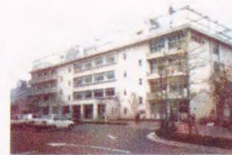
写真-1 <46>横浜市栄区役所（旧小学校） 校庭を駐車場に
