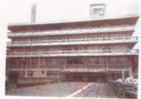
写真-4.6 〈2〉所沢市行政及び公共団体事務所 (旧市庁舎)
