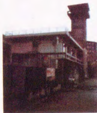
写真-4.4 〈86〉大阪市 南市民教養ルーム (旧消防署)
