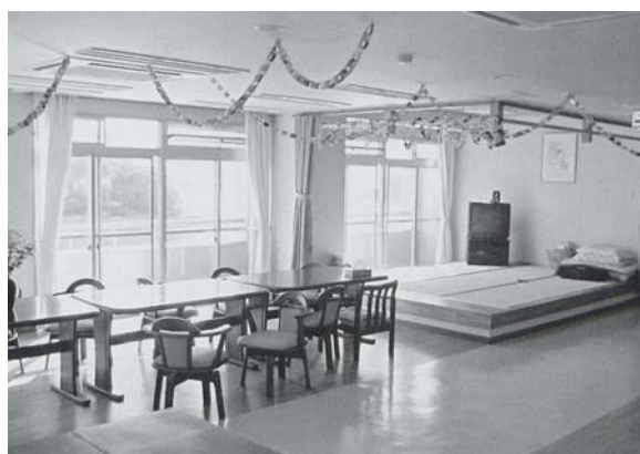
改修後の食堂と上部排煙窓
