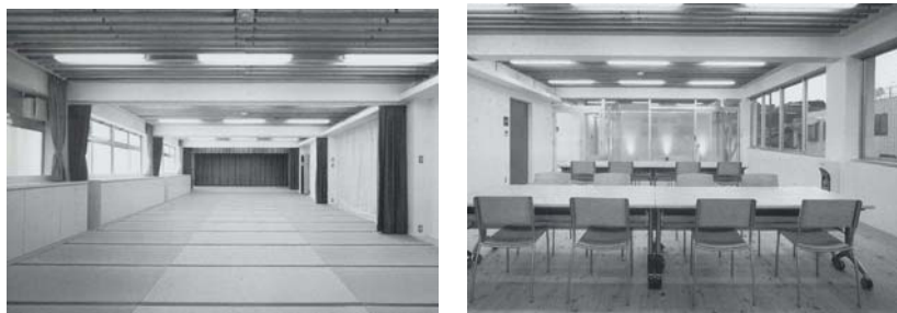
改修後 3 階交流室（左）と、3 階学習室（右）
