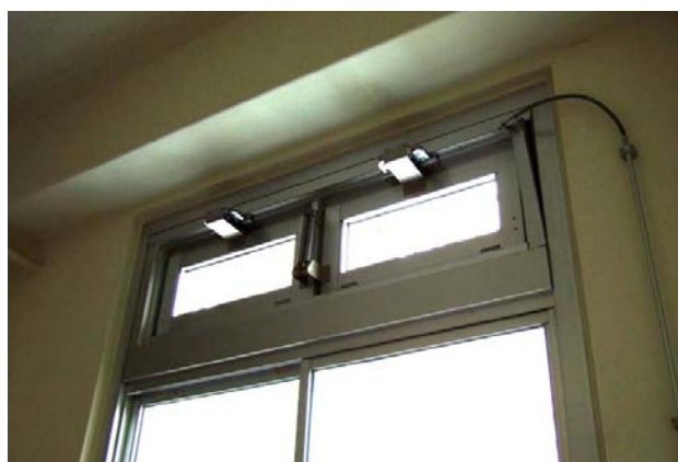
図 3-15 用途変更のために取り付けられた排煙オペレーター（左）と排煙窓（右）（旧開智小学校、現京都市学校歴史博物館）（2006 年 7 月著者撮影）
