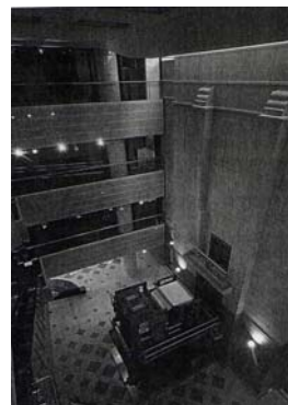
旧 38 条適用により堅穴防火区画が免除された中央階段（左）と 4 階から見下ろしたアトリウム（右）
