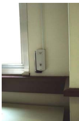
図 3-15 用途変更のために取り付けられた排煙オペレーター（左）と排煙窓（右）（旧開智小学校、現京都市学校歴史博物館）（2006 年 7 月著者撮影）
