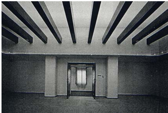
袖壁の躯体を一部撤去・補強し、3 階の床を抜いて天井を高くした 2 階ギャラリー（左）と 2 階の床を抜き天井の高いスペースを作り出したサロン（右）
