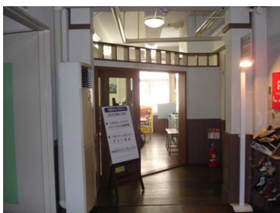
図 3-14 上部を欄間（左）にすることでギャラリーと中廊下の境界をあいまいにし、ギャラリーの排煙窓（右）から廊下の自然排煙が取れるようになっている。（旧北野小学校、現北野工房のまち）（2006 年 6 月大阪大学助教授（現大阪工業大学教授）より提供）
