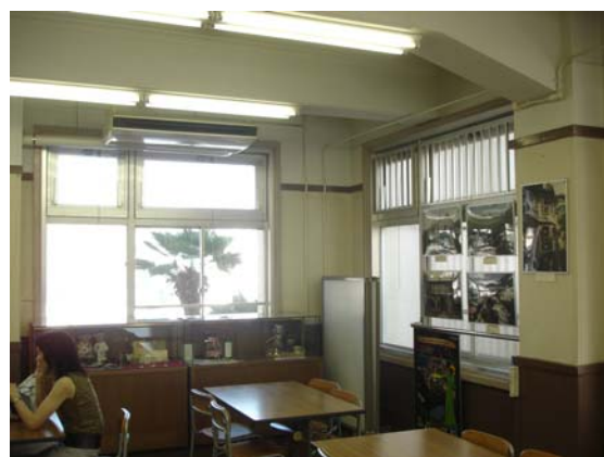
図 3-14 上部を欄間（左）にすることでギャラリーと中廊下の境界をあいまいにし、ギャラリーの排煙窓（右）から廊下の自然排煙が取れるようになっている。（旧北野小学校、現北野工房のまち）（2006 年 6 月大阪大学助教授（現大阪工業大学教授）より提供）
