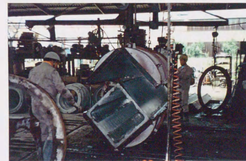
脱型後常圧蒸気養生
