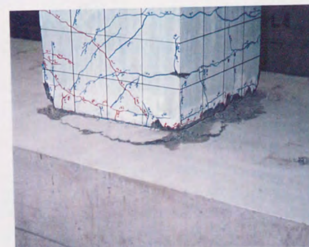
(2) 試験体PC-N 載荷終了時 柱脚部
