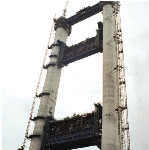
写真 2-4 Tsing Ma 橋主塔（RC 主塔）の架設 19)
