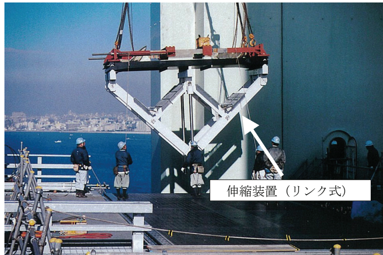
写真 7-8 伸縮装置（明石海峡大橋）
