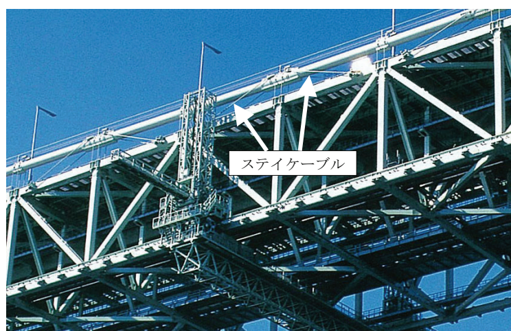
写真 7-7 ステイクケーブル（明石海峡大橋）
