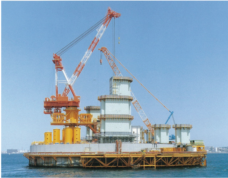
写真 2-3 明石海峡大橋主塔（鋼製主塔）の架設 16)
