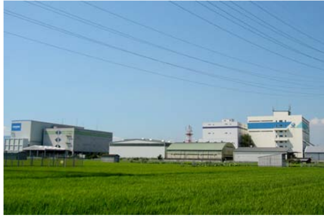
図 4-21 大規模建造物に隣接する農地(三島江地区)
