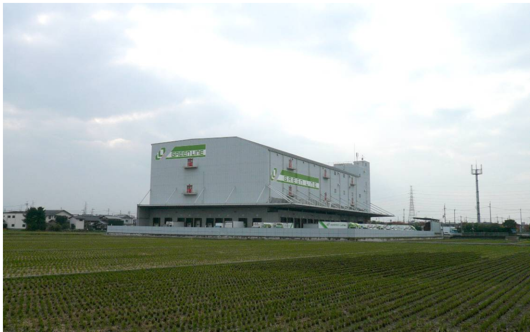
図 5-22 発生した立面が最大となった流通施設
