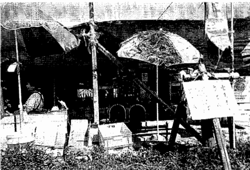
図4.57 仮設店舗(都賀川公園, 1995年10月10日)
