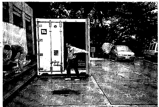
図6.9 電源工事が終わり、稼働し始めた保冷コンテナ(5月25日)
