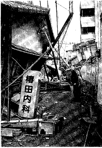
図7.6 家屋、電柱の倒壊や看板の落下で閉塞した5m道路 (灘区, 1月21日)
