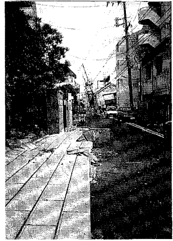
図7.8 門柱、ブロック塀の転倒 (灘区, 1月21日)
