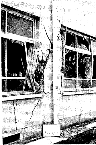
図 8.8 柱のせん断破壊により破損したガラス窓 (神戸市立鷹匠中学校東館) 〔写真提供：東京都立大学 北山研究室〕
