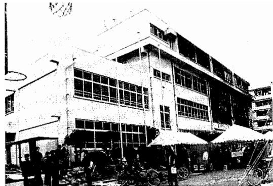
図 8.6 全焼した烏帽子中学校の本館
