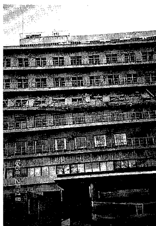
図 0.11 公立病院の被害の様子 (5階部分が押しつぶされる形で全壊した神戸市立西市民病院)
