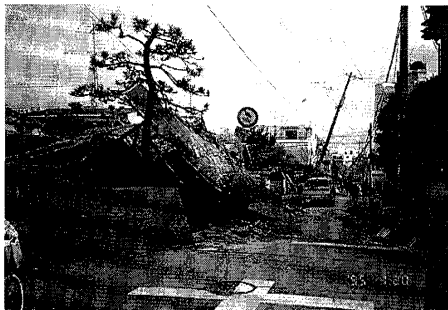
図0.3 木造住宅の倒壊の様子
