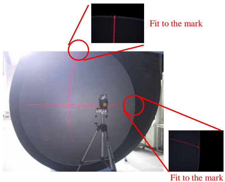
図 4.8 レーザー墨出し器設置状態 .
