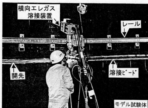
図7-8 大型モデル試験体の溶接状況
