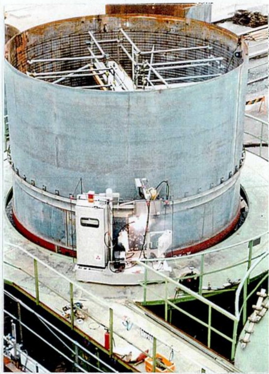
図 2-5 煙突筒身・周継手の全自動溶接システムの適用状況 (筒身径: 5.9m, 板厚: 10~15mm, 溶接法: セルフシールドアーク溶接法)
