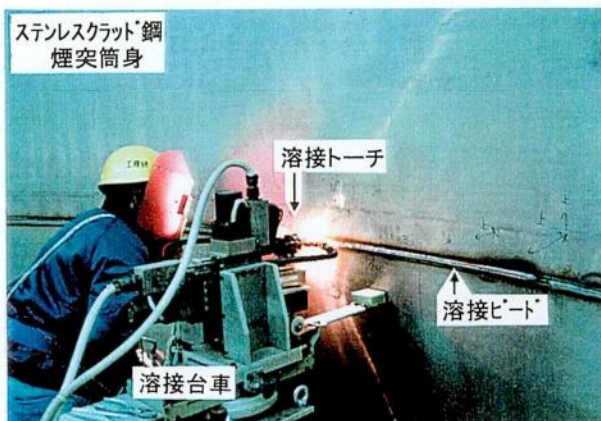
図 7-4 2 回付式横向姿勢 TIG 溶接法の実機適用状況
