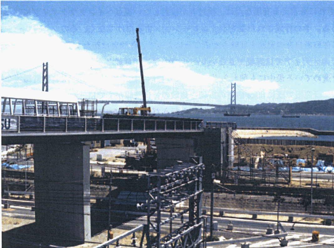
図4-13 施工の様子(1999年8月現在)
