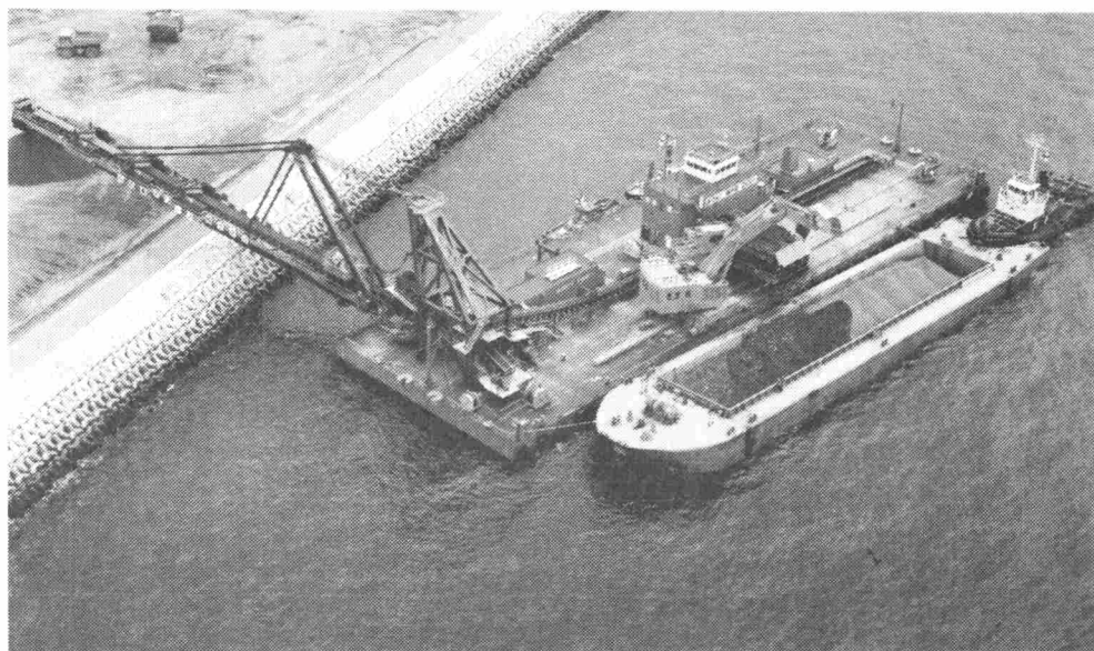
写真2-5 作業船に船を係留させて行う海洋工事
