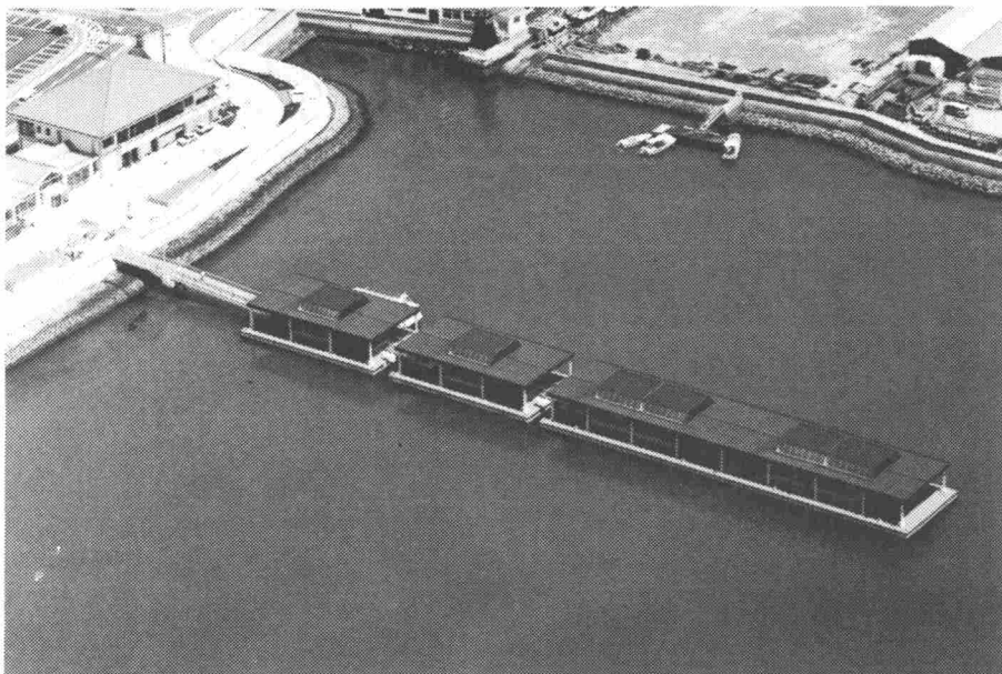
写真2-3 アンカー・チェーンによる小型船用浮体式係船岸
