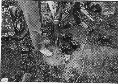
写真6. 14 振動計の設置状況
