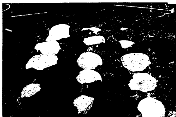
写真7.3 地中防振柱列の施工状況
