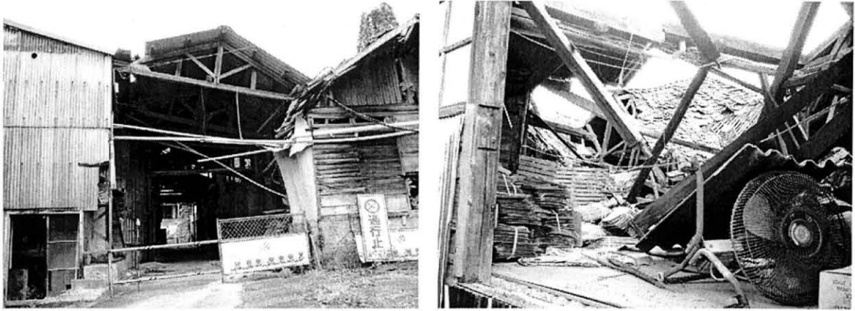
写真-1 工場跡地の様子 (撮影 2007年5月)
