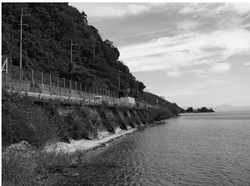
写真8 同上国道下の湖岸
