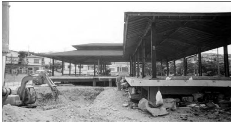
図 2-9 施工の様子—既存建物のスケルトンを残しつつ用途転換を図る (撮影：筆者)
