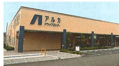
図 1-13 モールラフィーネ (西近隣センター)
