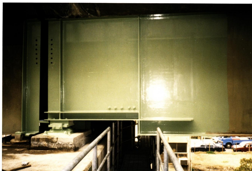
写真-1.2 改造後の実橋
