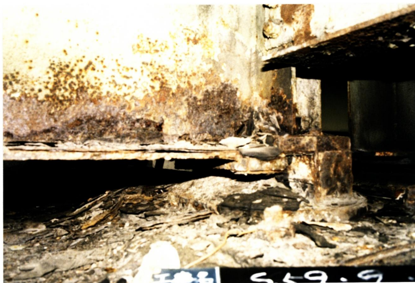
写真-1.1 腐食による断面欠損
