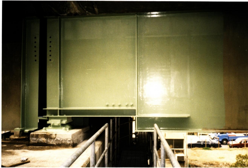
写真-1.2 改造後の実橋
