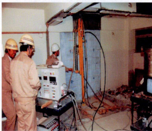
Photo 4. 6 切断中の状況
