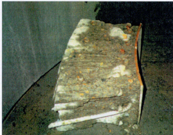
Photo 4. 4 切断されたブロック
