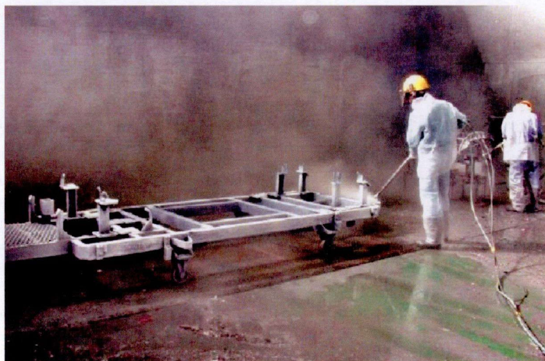
Photo 1.8 塗装台車の剥離洗浄状況
