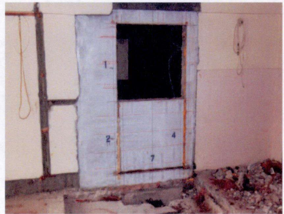
Photo 4. 7 切断後の状況
