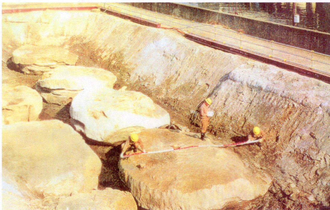
Photo 1. 14 スーパージェット工法で造成された改良体
