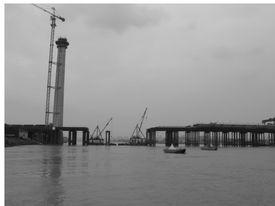
写真 5 南京市街と結ぶ橋梁の工事
