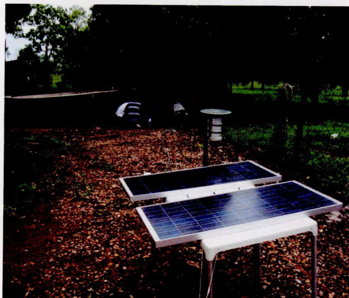
図 3.2: LF 帯受信機の設置写真。
