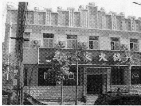
写真 4-41 改造されたファサード
