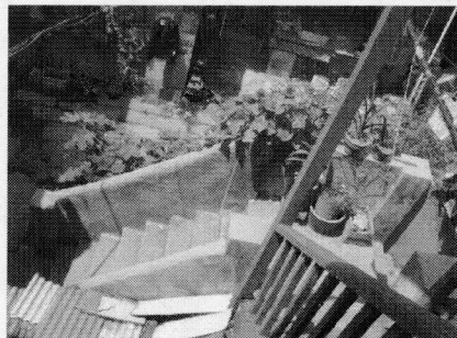
写真 4-18 修復された階段
