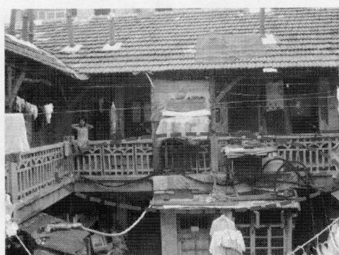
写真 1-3 下水道用の PVC パイプ
