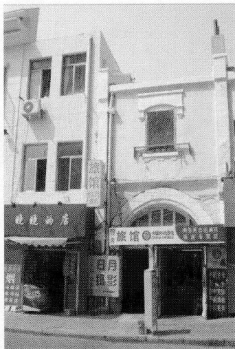
写真 4-2 アーチ形入口
