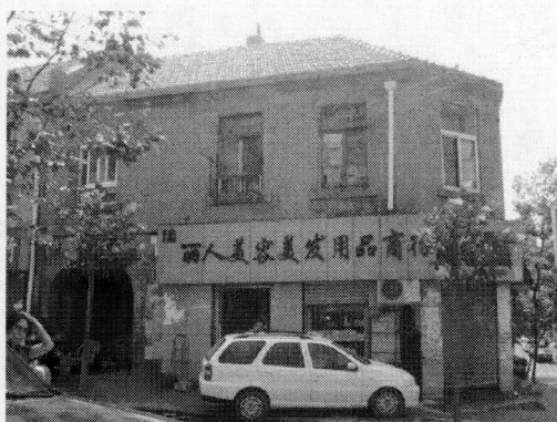
写真 4-30 道路から見た北側の建物
