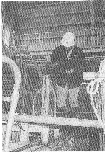
写真-4.4.6 杭模型の牽引状況
