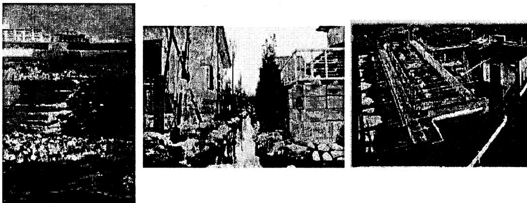
図4 水域直接浄化事例の目的による分類の例, A: 自然型, 瀬と淵浄化法, 大和川, 大阪府 B: 環境整備型, 接触濾材充填酸化法, 排水路, 新潟県, C: 機能型, 曝気付き接触酸化法, 都川, 千葉県
