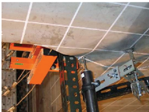
写真-2.2.3 フィレットの変形 (試験体 1, +2δ y )
