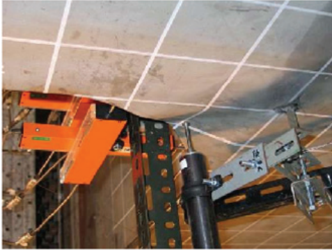
写真-2.2.3 フィレットの変形 (試験体 1, +2\delta_y )
