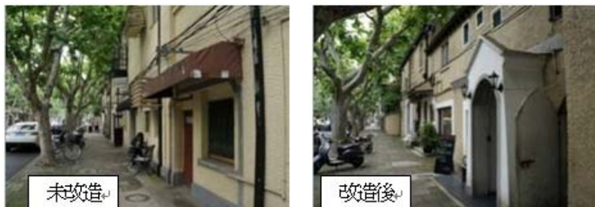
写真 5-2 沿道側の外壁の改造状況
