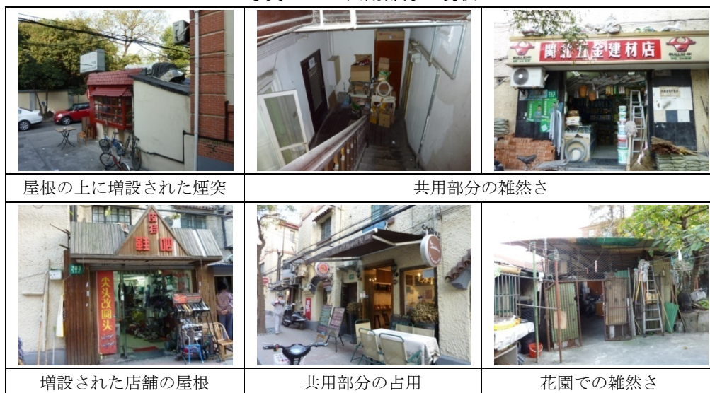
写真 4-6 共用部分の現状
