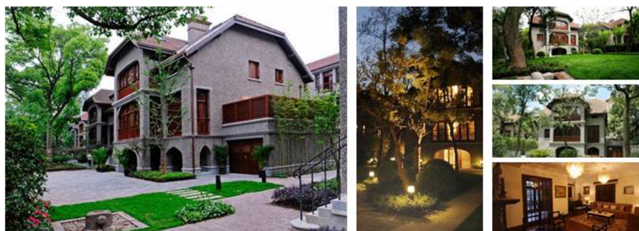
写真2-2 思南路にある修復後の花園住宅
