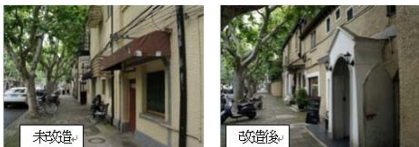
写真 5-2 沿道側の外壁の改造状況
