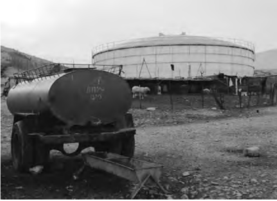
ベドウィン・コミュニティのカーズ二地区。手前はベドウィンの水タンク。後ろには入植者用の貯水施設が見える。
