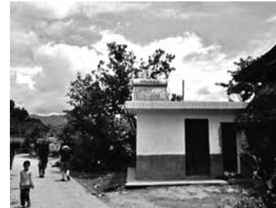
写真2：太陽熱給湯機
