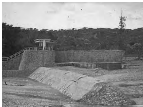
写真2:旧システムのチェックダム(写真提供:東ティモール農漁業省マヌファヒ県農業事務所)
