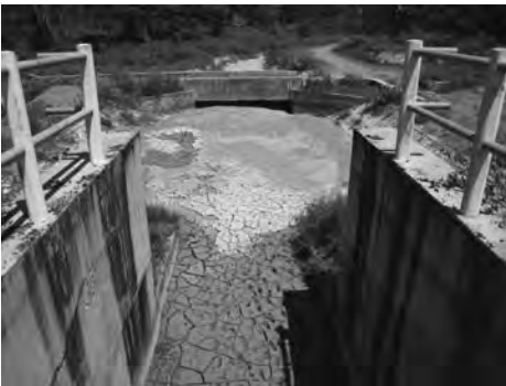
写真8：幹線水路入口における土砂の堆積(2010年3月24日、筆者撮影)
