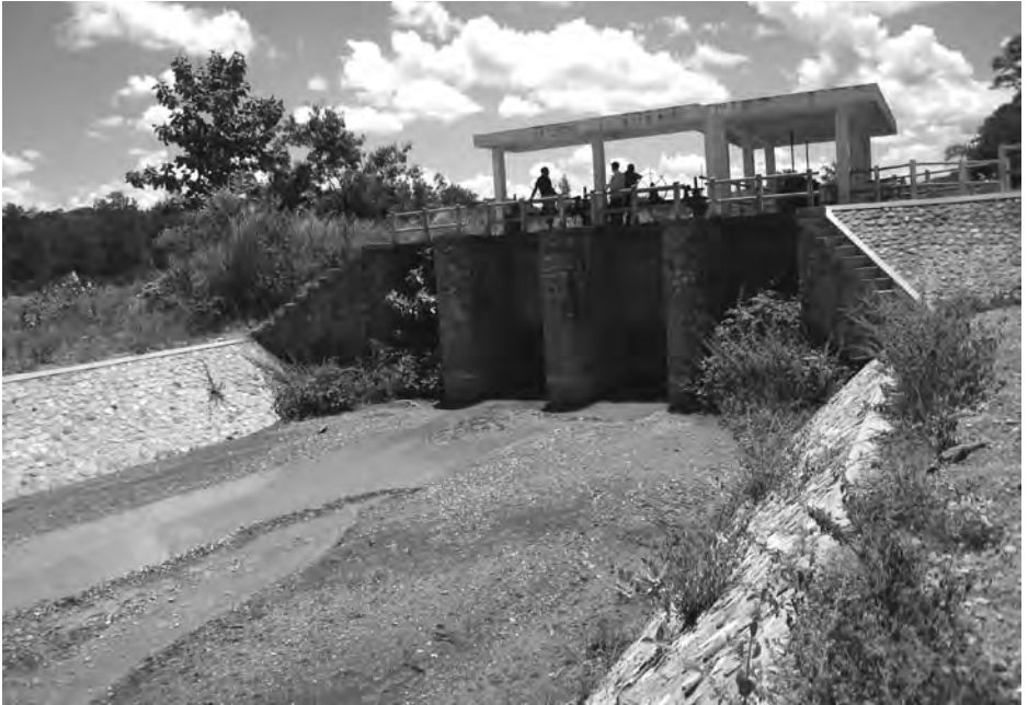
写真7：排砂ゲート裏から排砂路(2010年3月24日、筆者撮影)
