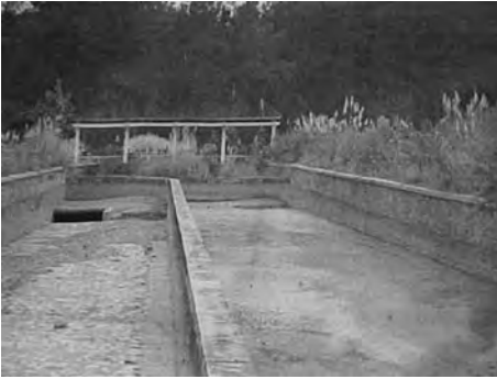
写真4:旧システムの沈砂池/取り付け水路(2)
