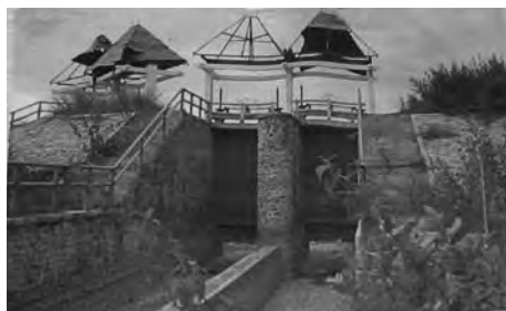
写真3:旧システムの沈砂池/取り付け水路(写真提供:東ティモール農漁業省マヌファヒ県農業事務所)
